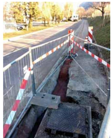
Seit November finden die ersten Arbeiten zur Verlegung der Glasfaserleitungen statt. Zuerst werden die POP eingerichtet und die Telefonzentralen erneuert, dann die öffentlichen Gebäude angeschlossen.
