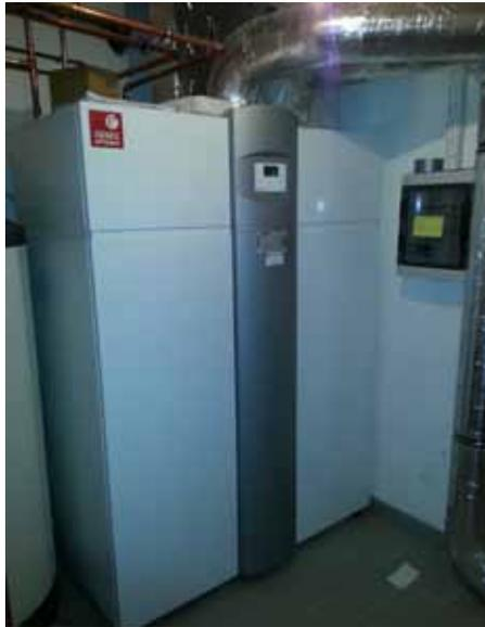
Herzstück Haus Fliri, das Kompaktaggregat beinhaltet Wärmepumpe, Lüftungsanlage und den Warmwasserspeicher.
