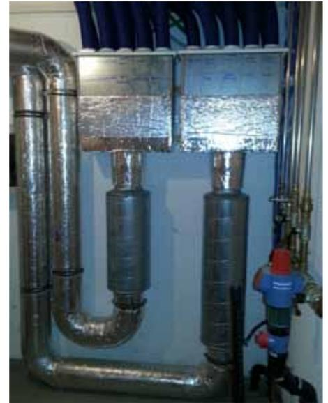
Verteiler und Schalldämpfer der Lüftungsanlage im Haus Fliri.
